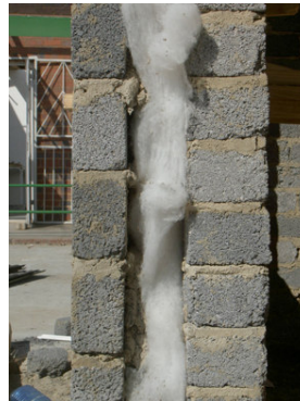
Bild 4: 2-schaliges Mauerwerk
