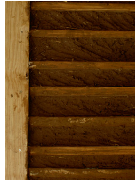
Bild 7: Ausfachen der Innenseite mit Lehm
