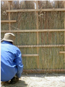
Bild 5: Aussenschalung
